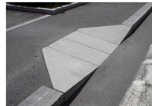
Esempio di inserimento in pavimentazione di asfalto
