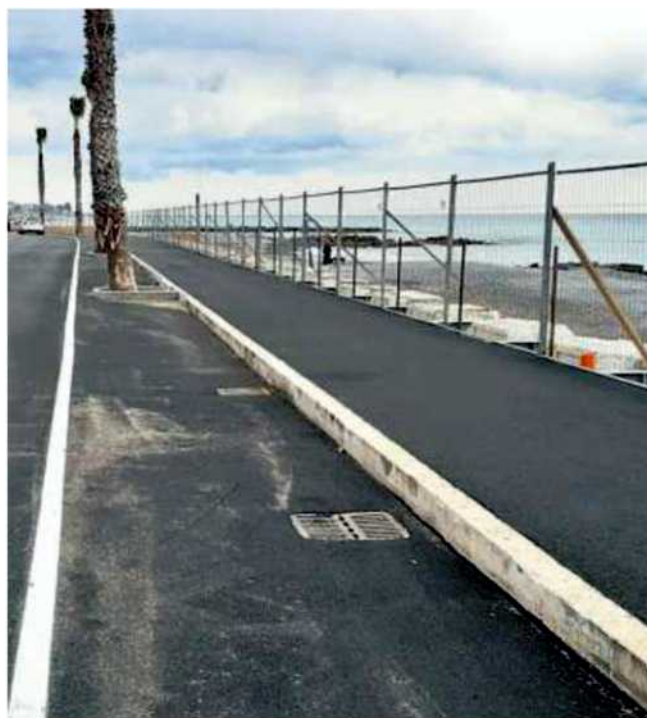
La pista ciclopedonale a sbalzo in fase di realizzazione a Ventimiglia
